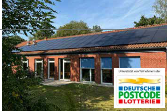
Neue PV-Anlage auf der Dach der Hauswirtschaft
