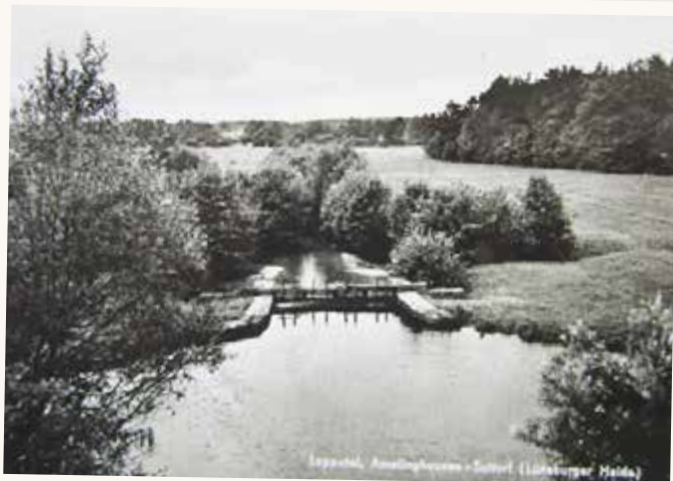
Das Wehr an der B 209
